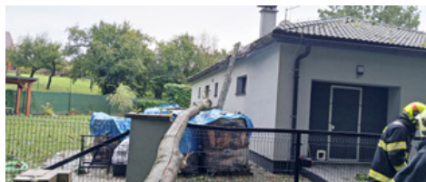
Strom na rodinném domě v Horních Domaslavicích.
